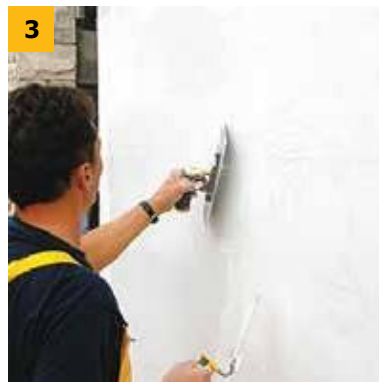
3. Shtrirja dhe rrafshimi i shtresës së dytë ku mbulohet rrjeti tërësisht 1-2mm
