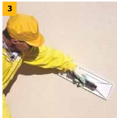
3. Shtresa finale mund të jepen nga shtresa tjera apo fasada silikate duke iu përmbajtur udhëzimeve të prodhuesit.
