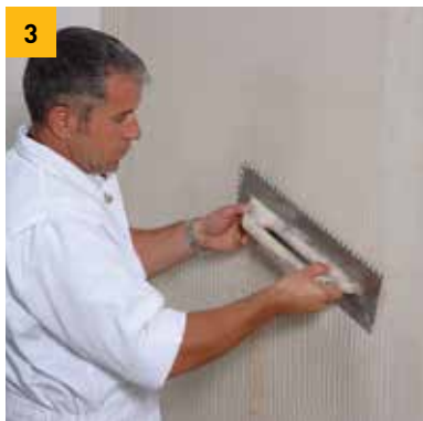
3. Vendosja e rrjetit të armuar 4x4 mm dhe në vazhdim të saj për 10 cm njëra mbi tjetrën, rrjeti duhet të jetë plotësisht i futur në masë llaçi
