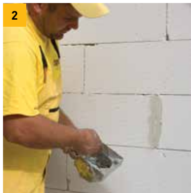
2. Murit Ytong duhet paraprakisht t'i mbulohen hapjet me masë llaçi, shtresa e hollë shpërndahet me rrafshuese me thellësi dhëmbzori 10mm
