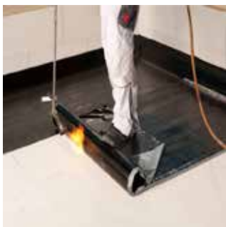
Shtrirja e shtresës hidroizoluese.
