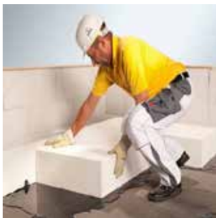
Shtrirja Multipor në dysHEME, bitumen i nxehtë.
