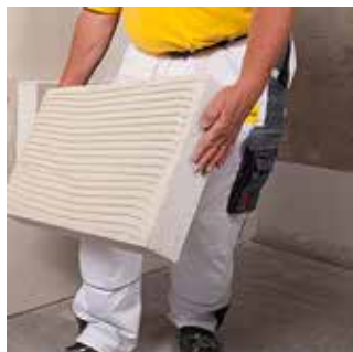
Shtrirja Multipor në dysHEME, bitumen i nxehtë.
